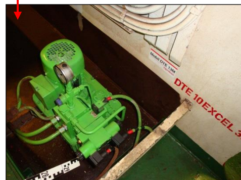
Abbildung 12: Hydraulikmotor der Steuerung befindet sich auf dem Boden unter den Schaltschränken
