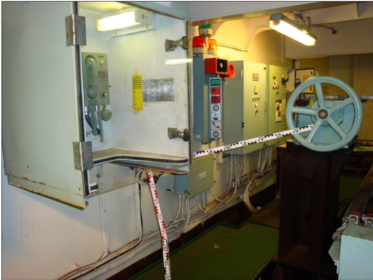
Abbildung 14: Abstand zwischen Telefon und Handrad für Notruderbetrieb
