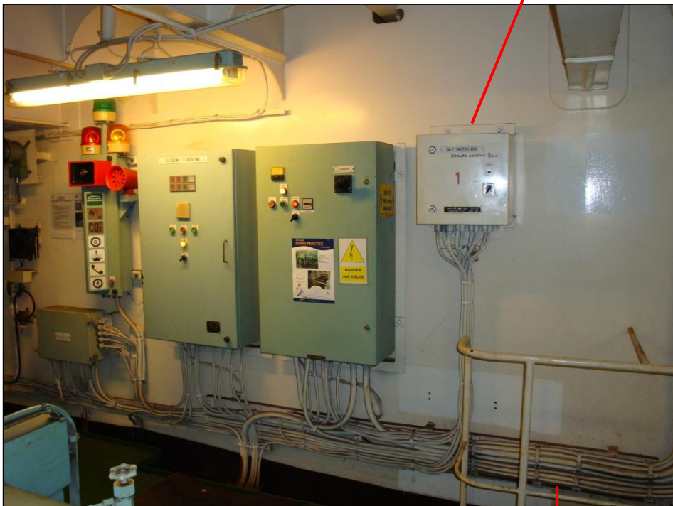
Abbildung 11: Schaltschränke der Rudermaschine
