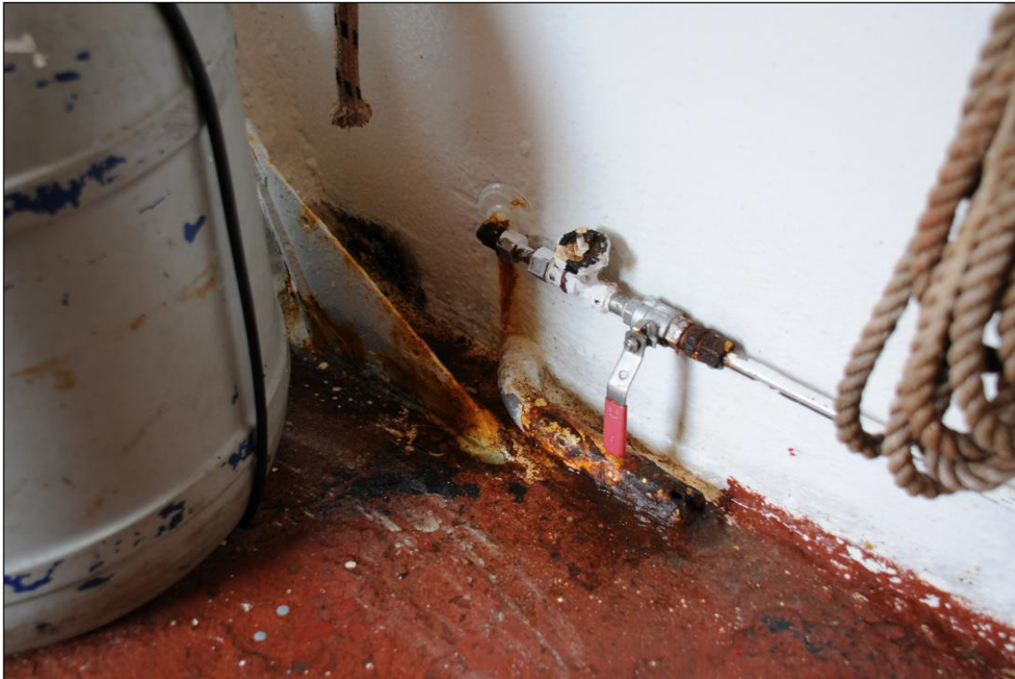
Abbildung 5: Hauptkugelhahn mit vorgeschaltetem Drosselnadelventil
