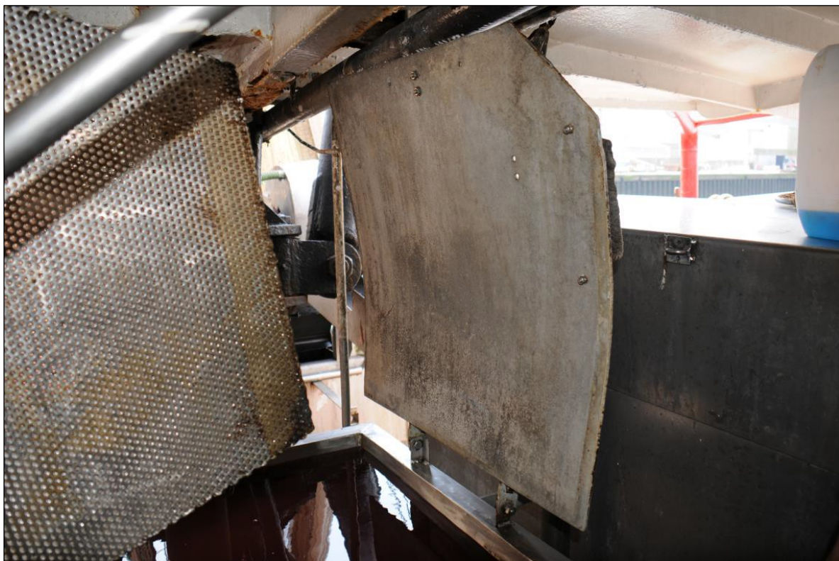
Abbildung 17: Deckelanschlag an der Decksstruktur
