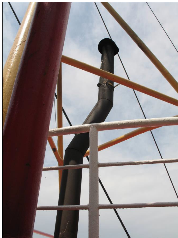
Abbildung 13: Abgasleitung über der Back
