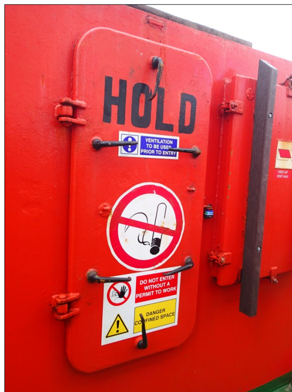
Abbildung 14: Laderaumzugang und Lüftungsklappe
