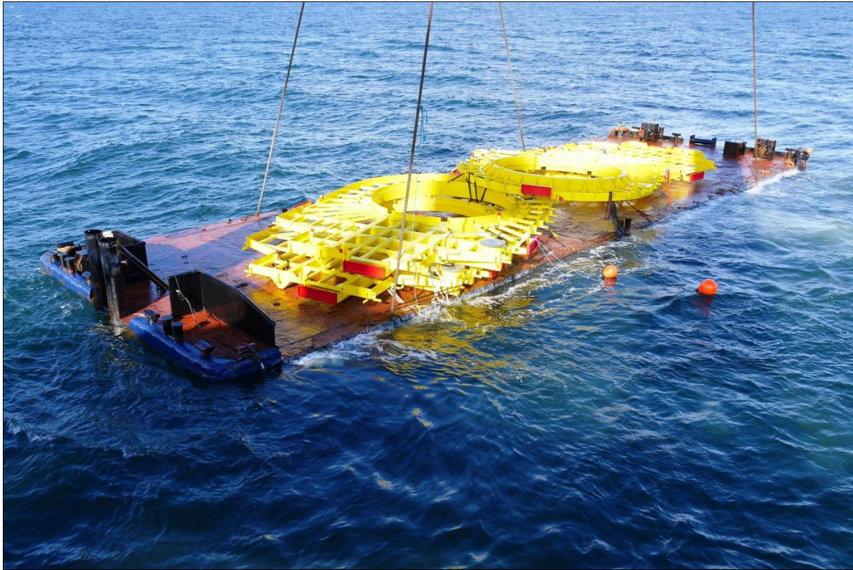
Abbildung 10: PONTON 1 gehoben
