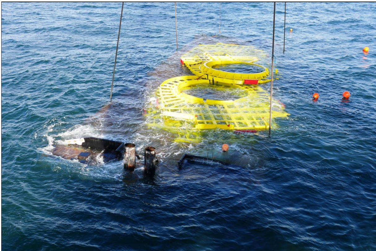
Abbildung 9: Ponton 1 wird gehoben
