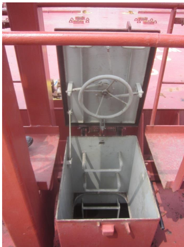
Abbildung 5: Zugang Laderaum 9 vom Hauptdeck
