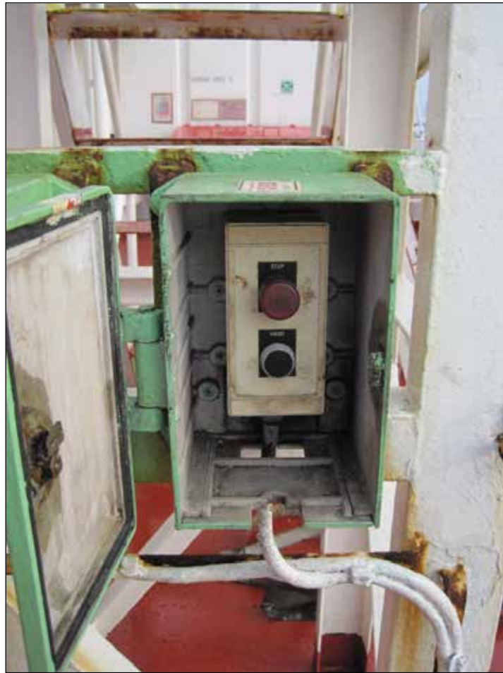
Abbildung 19: E-Heben/Not-STOPP-Drucktaster neben der Davitanlage
