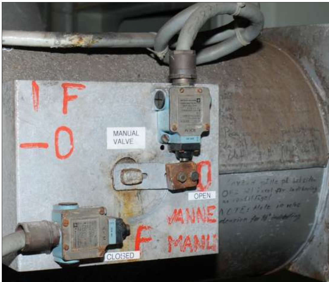
Abbildung 34: Haupttankventil mit handschriftlichen Bedienhinweisen
