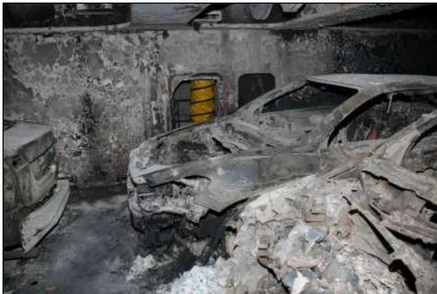
Abbildung 45: Entstehungsort des Brandes
