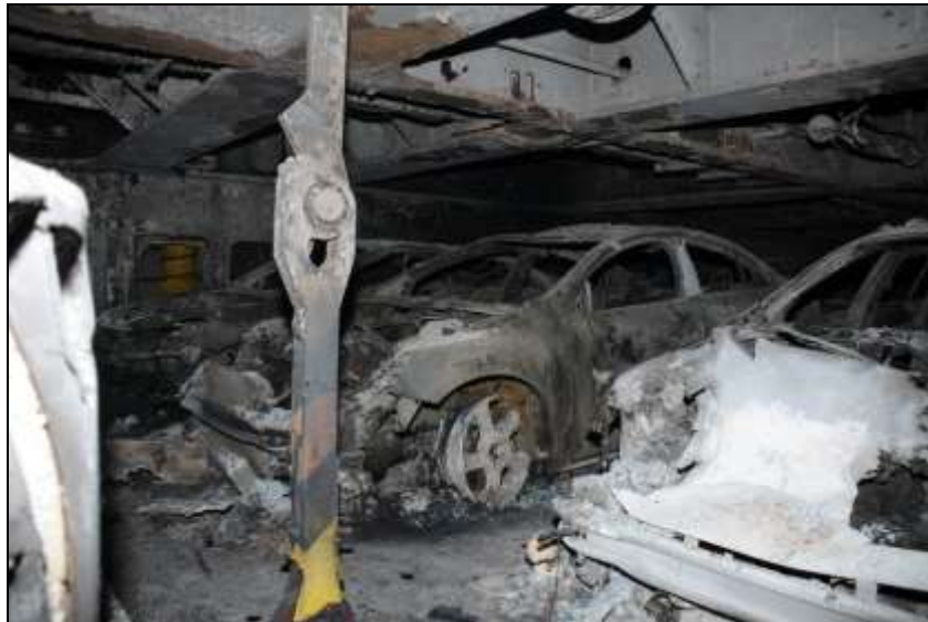
Abbildung 44: Offensichtlicher Brandenstehungsort Bay 26
