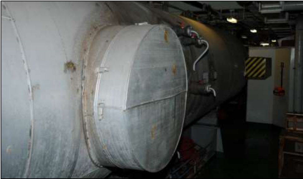
Abbildung 16: CO2-Niederdrucktank
