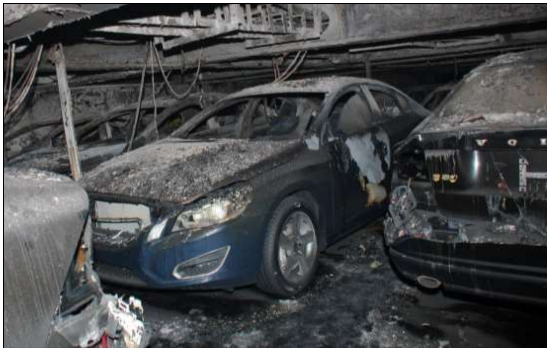
Abbildung 8: Durch Hitze unterschiedlich stark beschädigte PKW
