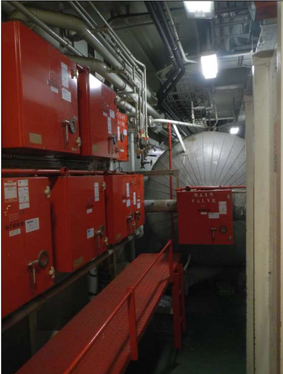
Abbildung 21: Links Bedienkästen zur Ansteuerung der einzelnen Flutungszonen 26
