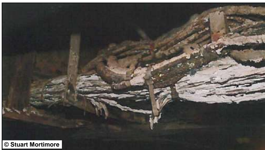
Abbildung 80: Kabelspleiß oberhalb von Fahrzeug 5 B 53
