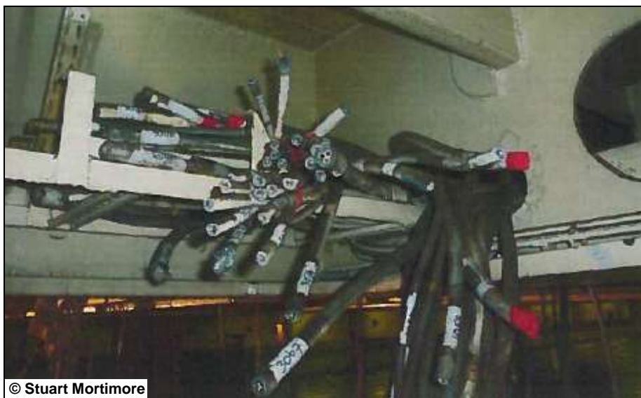
Abbildung 82: Für Reparaturzwecke markierte Kabel 55
