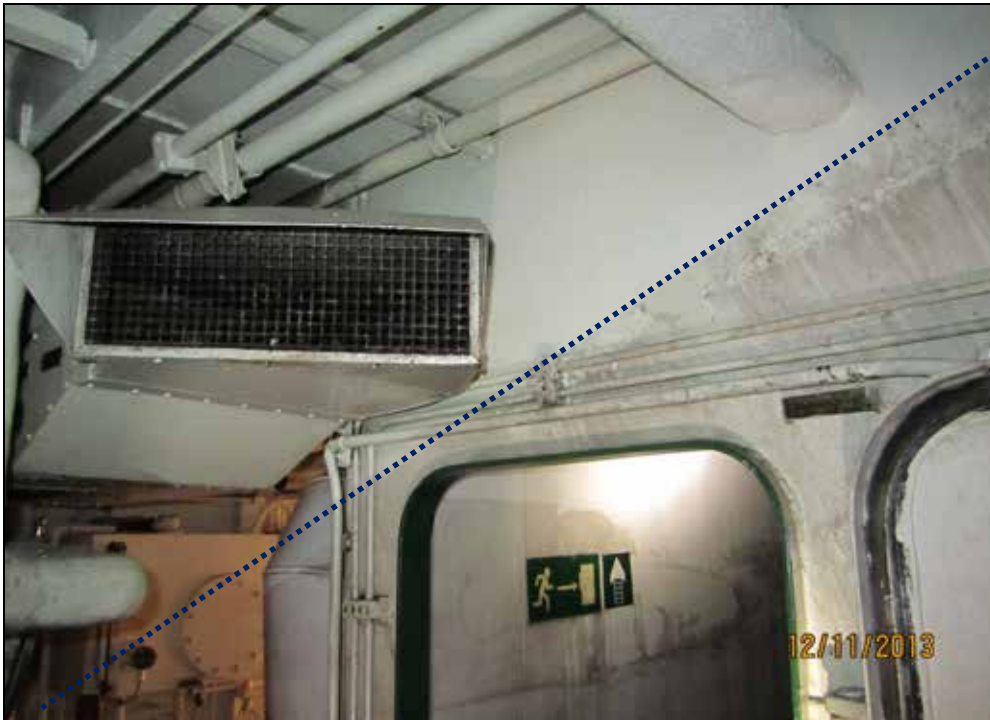
Abbildung 45: Nachweis der nach Backbord hin zunehmenden Flutung des Maschinenraums
