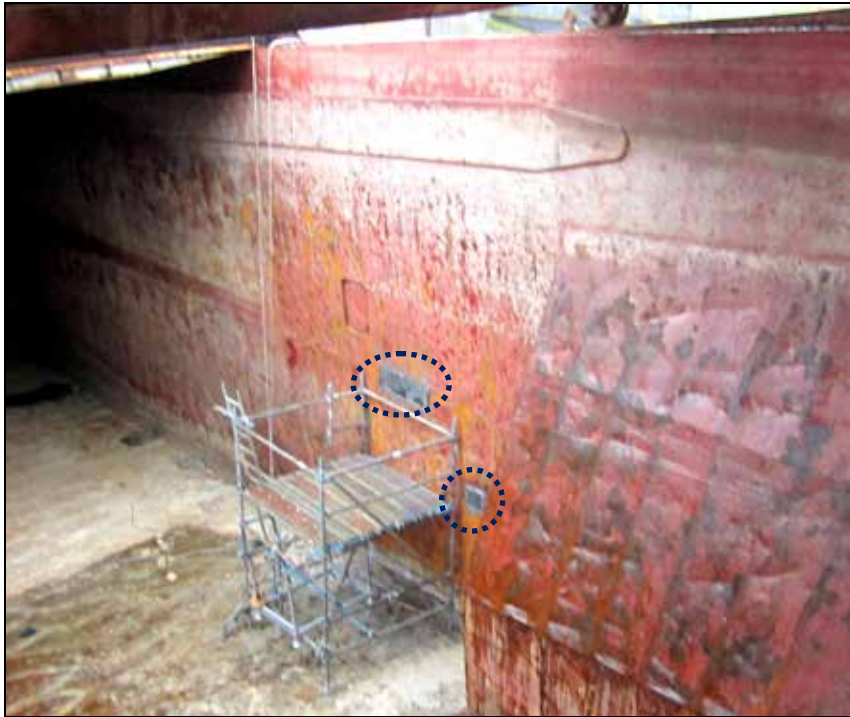
Abbildung 43: Löcher in der Laderaumwand (Laderaum 1, Backbordseite) 30
