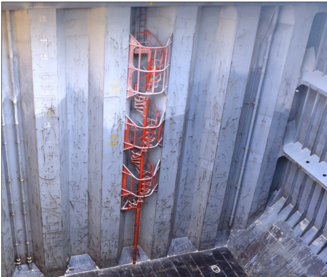
Abbildung 6: Wendeltreppe an der Vorkante von LR3
