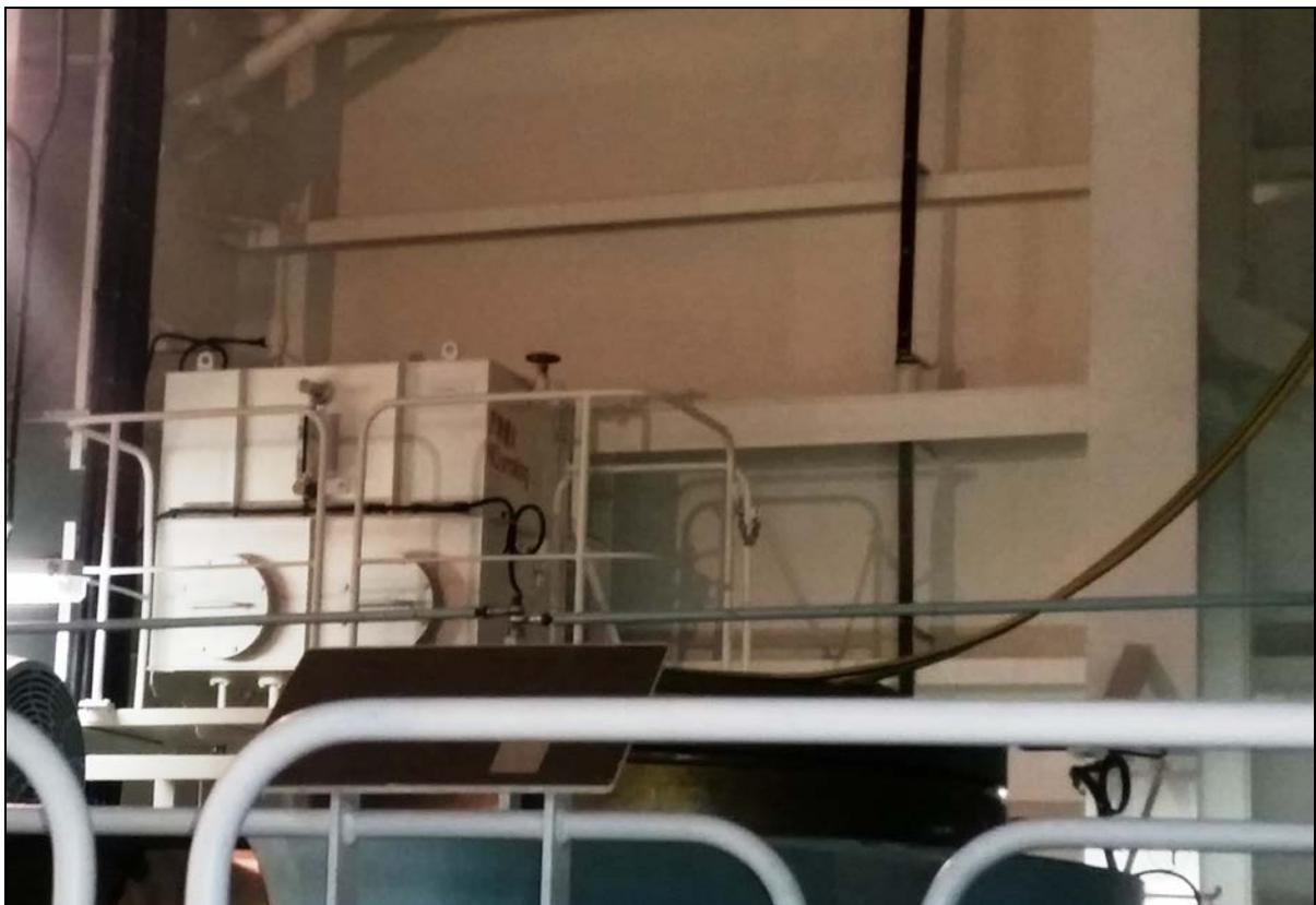
Abbildung 18: Hydrauliköltank
