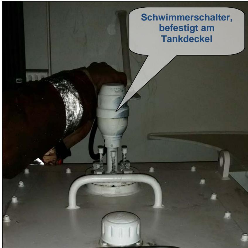
Abbildung 19: Hydrauliköl-Tankdeckel mit Schwimmerschalter
