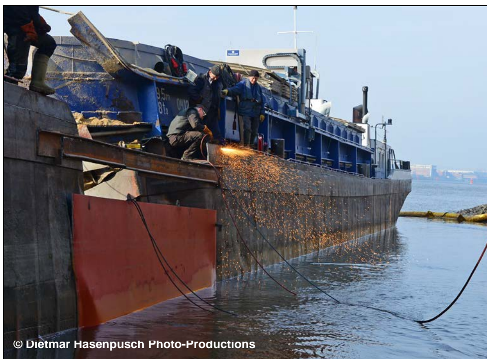
Abbildung 20: BMS JADE – Leckabdichtung
