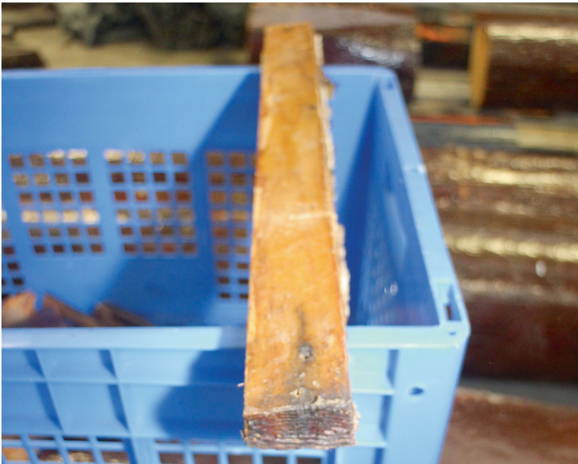
Abbildung 46: Eine der für die Instandsetzung verwendeten Füllleisten. Foto: Untersuchungsrat für Sicherheit
