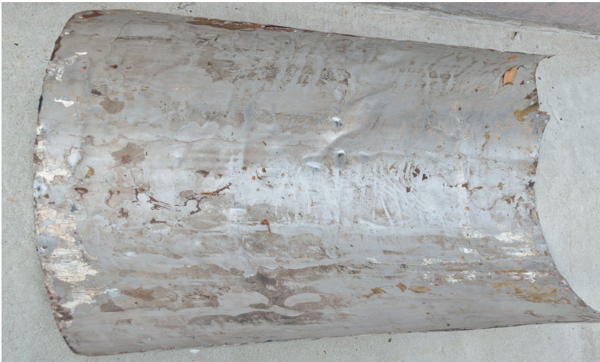
Abbildung 14: Innenfläche der Mastmanschette mit ausgehärteten Klebstoffresten. Quelle: Untersuchungsrat für Sicherheit
