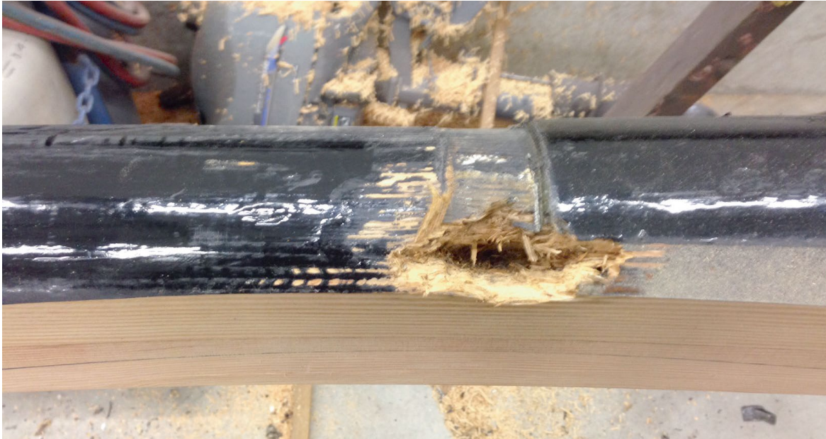
Abbildung 18: Beispiel von Holzfäule unter einer Befestigungsstelle an einem Holzmast. Quelle: Jachtwerf fa. M. van Duivendijk
