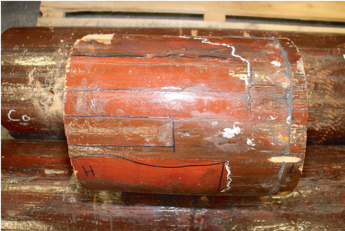
Abbildung 12: Mastbereich hinter der Mastmanschette mit sichtbaren Reparaturen. Quelle: Untersuchungsrat für Sicherheit
