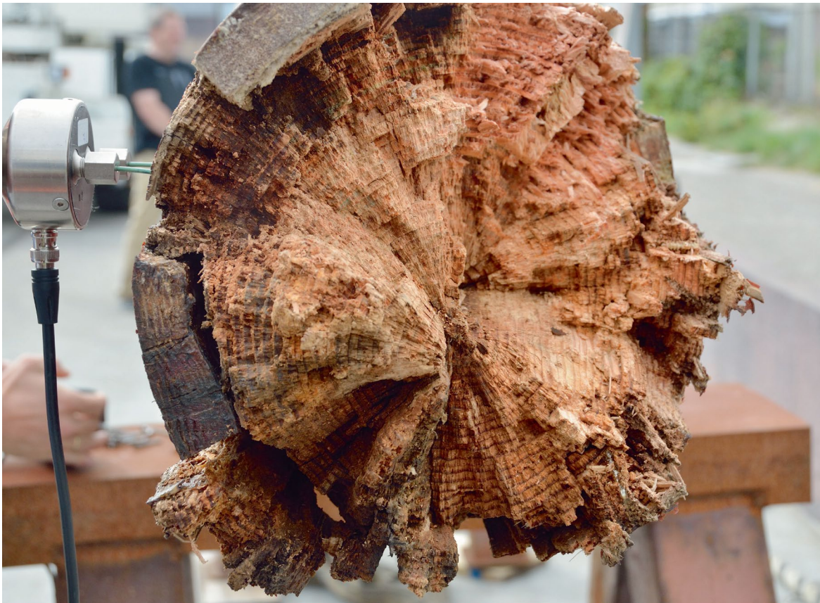
Abbildung 37: Bruchstelle des Masts. Foto: niederländische Polizei
