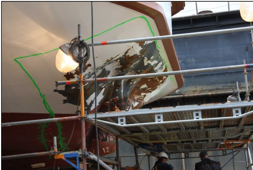
Abbildung 14: Schaden im Bugbereich der Fähre, Seitenansicht
