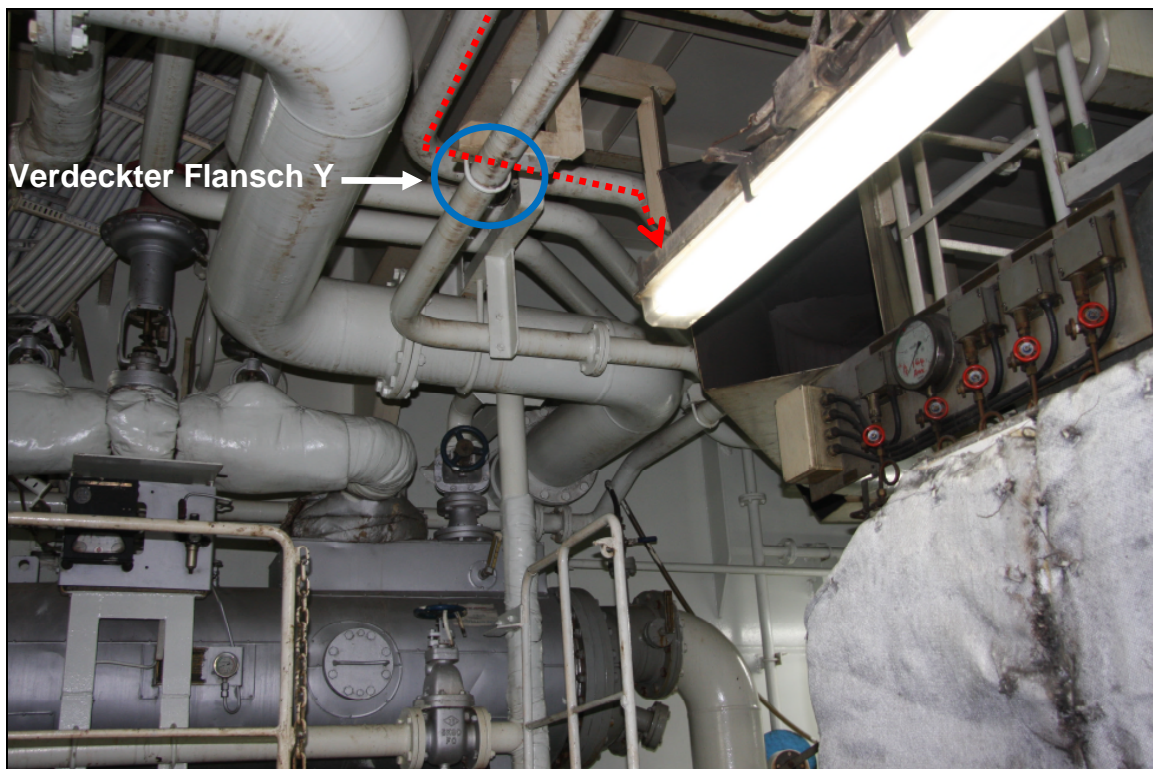
Abbildung 9: Verlauf des Abflussrohres (Nahaufnahme C)
