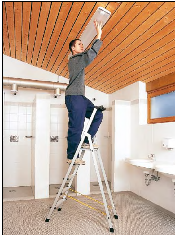
Abbildung 15: „Sicherer Stand auf der Stehleiter mit Plattform“ laut DGUV 208-016 23
