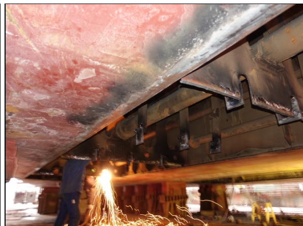
Abbildung 5: Bodenschäden
