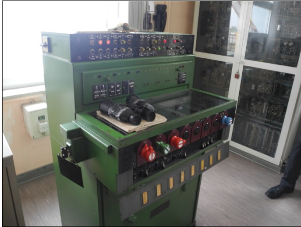
Abbildung 29: Steuerung der Signale
