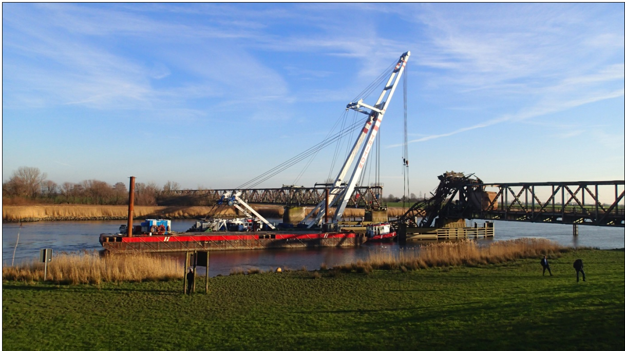
Abbildung 3: Bergung der Brückenklappe
