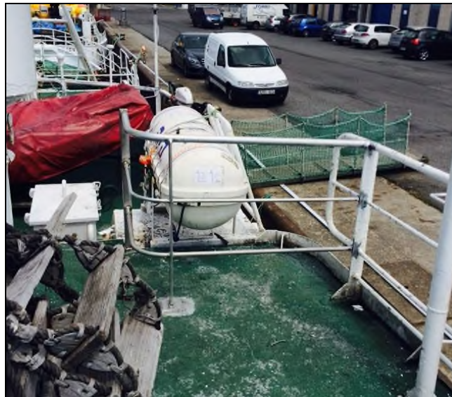
Abbildung 4: Ansicht der Relling nach dem Umbau
