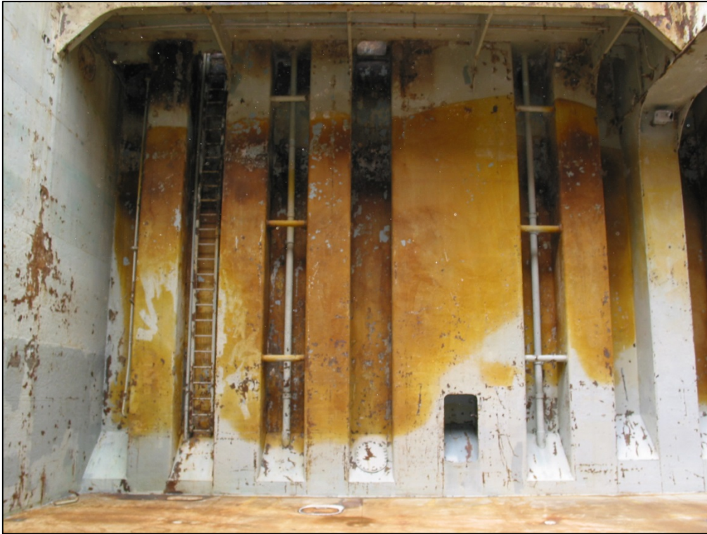
Abbildung 62: Unterraum Laderaum 2, Achterkante Steuerbordseite
