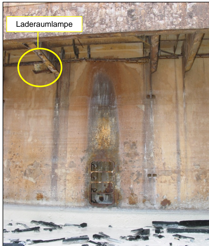
Abbildung 22: Laderaum 3, Zwischendeck, Backbordseite, Lüftungsschacht im Schott zu Laderaum 2
