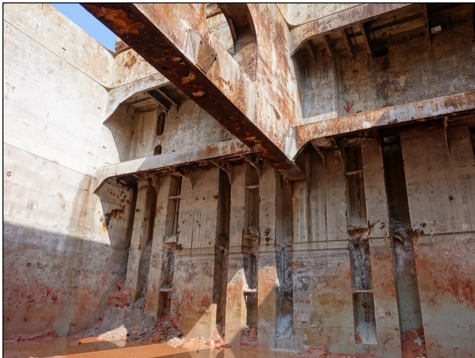
Abbildung 41: Achterkante Laderaum 3, Steuerbordseite
