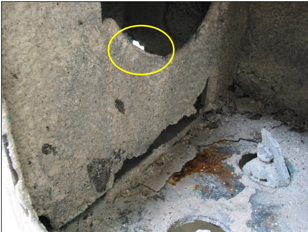
Abbildung 36: Blick in die Öffnung zu Zwischenraum A und B Gelb markiert: Durchrostung im Schott zu Laderaum 3 (siehe auch Abbildung 31)
