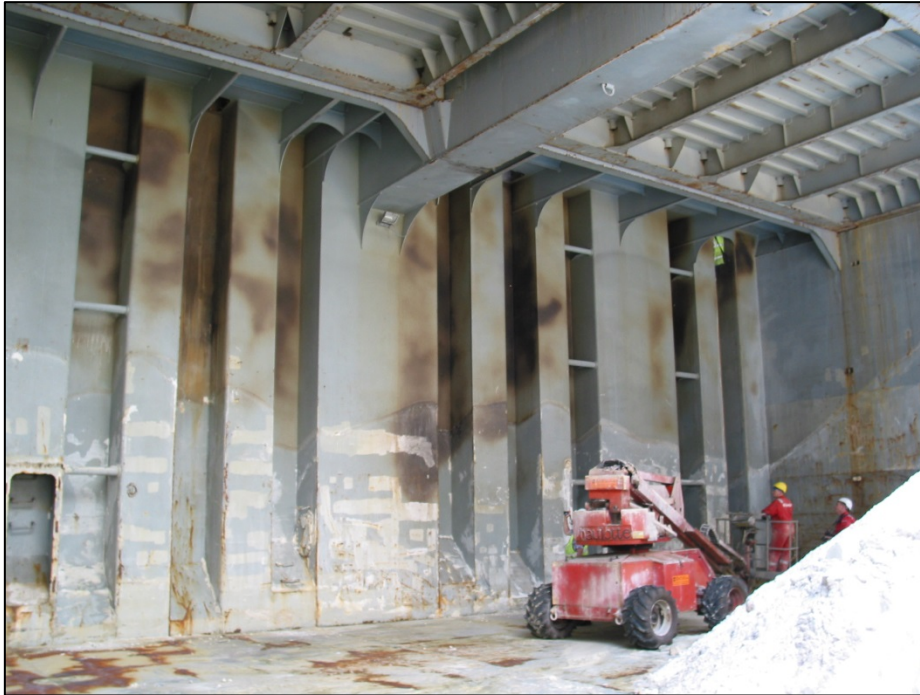
Abbildung 45: Laderaum 4, vorderes Querschott, Blick in Richtung der Steuerbordseite
