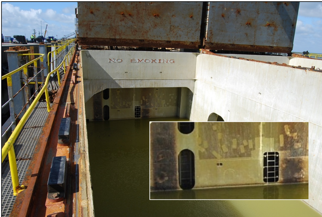
Abbildung 19: Laderaum 2, Zwischendeck, Steuerbordseite achtern, 05.06.2015
