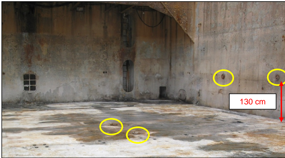
Abbildung 27: Zusätzlich angebrachte D-Ringe (gelb markiert)
