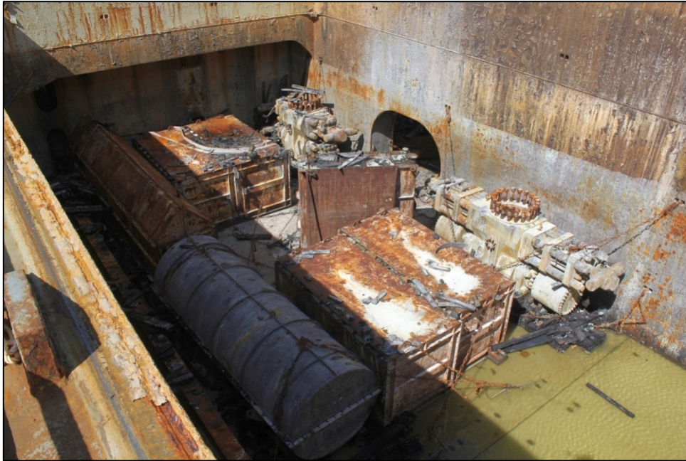
Abbildung 21: Laderaum 3, Zwischendeck, Steuerbordseite achtern, 08.06.2015
