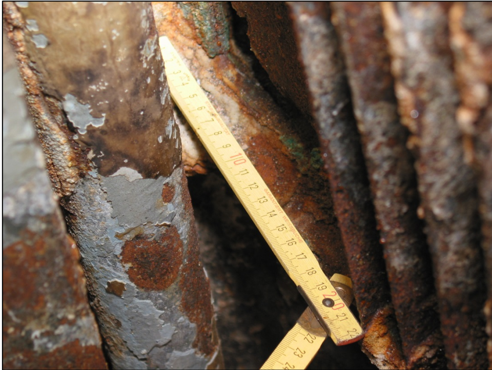
Abbildung 60: Schacht der Raumleiter zu Laderaum 2
