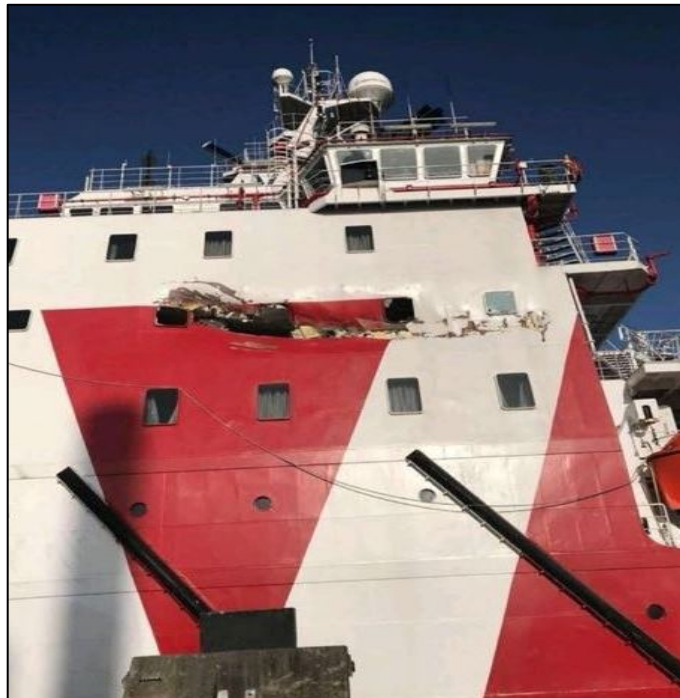
Abbildung 14: Schaden an den Aufbauten
