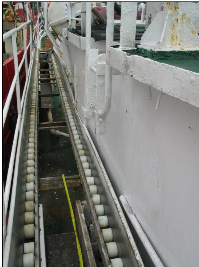
Abbildung 15: Kurze Leiter zum Peildeck und Ablaufbahn
