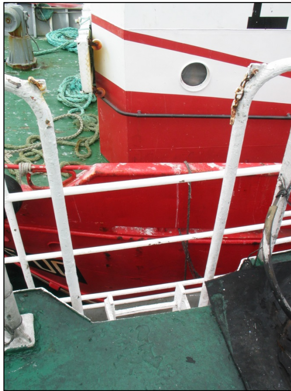
Abbildung 16: Durchgang der Leiter zum Peildeck ohne Sicherungskette
