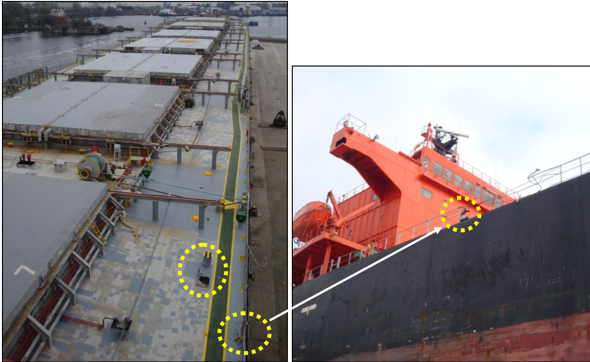
Abbildung 10: Positionen des zerstörten Pollers und der aufgebrochenen Klüse
