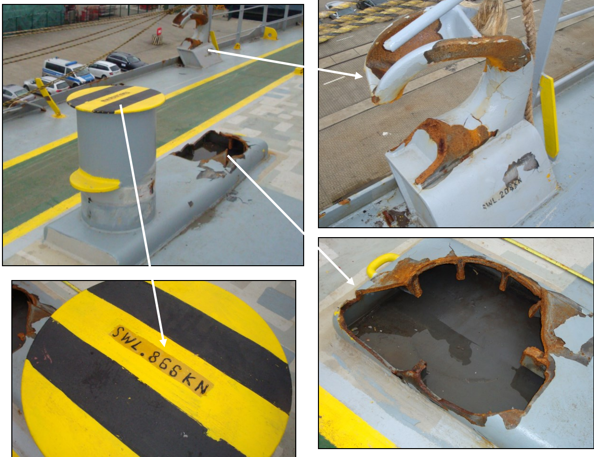
Abbildung 11: Nahaufnahmen des zerstörten Pollers und der aufgebrochenen Klüse
