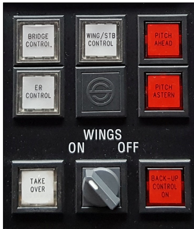
Abbildung 29: Ausschnitt aus dem Bedienpanel der Verstellpropelleranlage auf der Brücke
