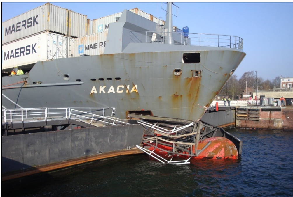
Abbildung 4: Die AKACIA und das durchbrochene Schleusentor
