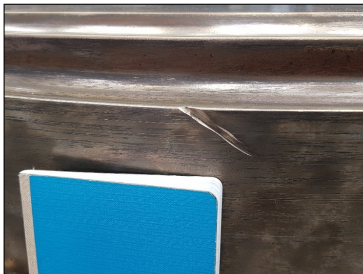
Abbildung 53: Einkerbung am Lagerteller
