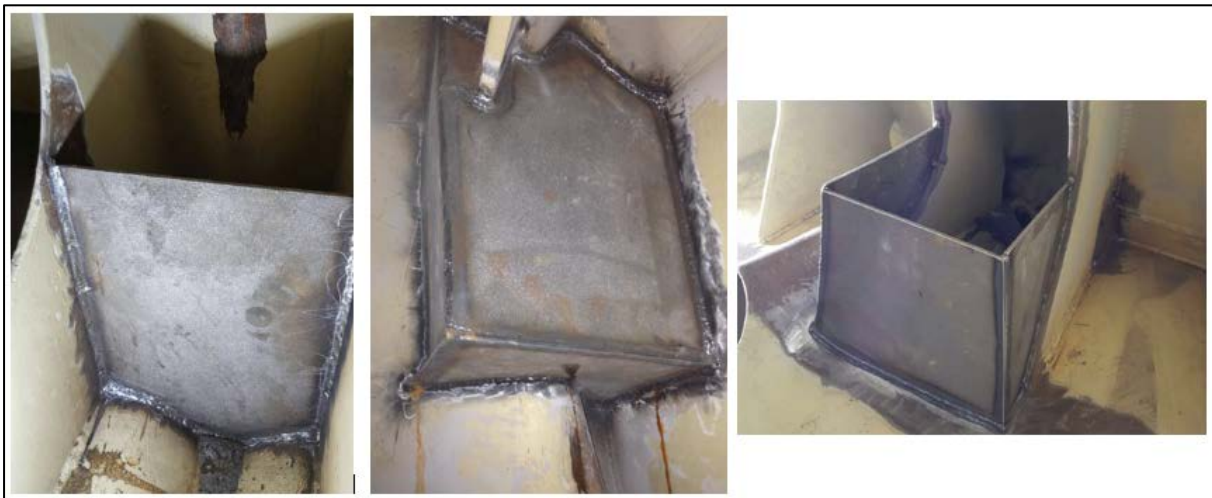
Abbildung 9: Kastenkonstruktion in Rissbereichen
