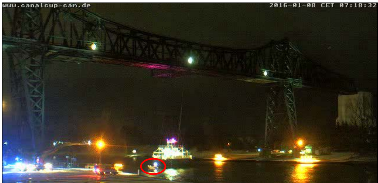
Abbildung 15: Rettungsmaßnahmen: Kontaktaufnahme mittels Schlauchboot, 08.01.16, 07:18 Uhr
