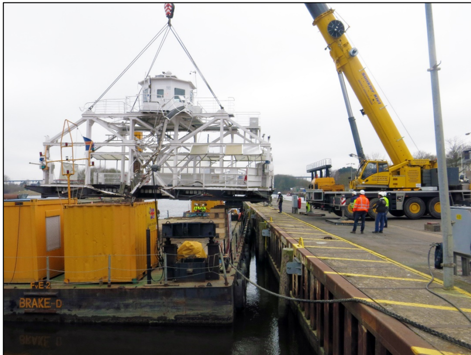
Abbildung 22: Entladen der Schwebefähre auf dem Bauhof des WSA
