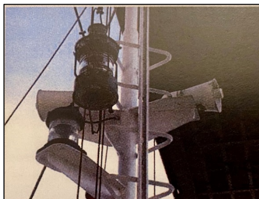
Abbildung 37: Signalhorn der Schwebefähre
