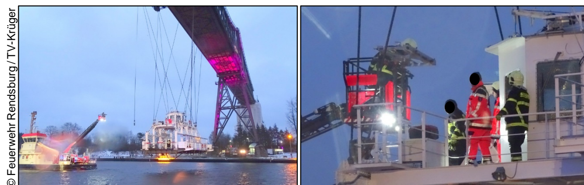
Abbildung 18: Rettungsmaßnahmen: Rettungskräfte auf der Schwebefähre
