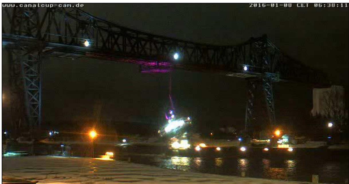
Abbildung 10: Hochschleudern der Schwebefähre, 08.01.2016, 06:38 Uhr
