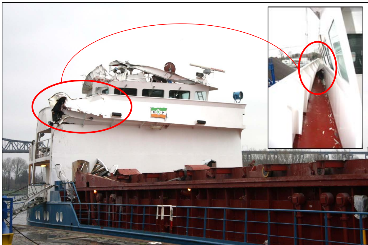
Abbildung 27: Überblick: Schäden an den Aufbauten der EVERT PRAHM
