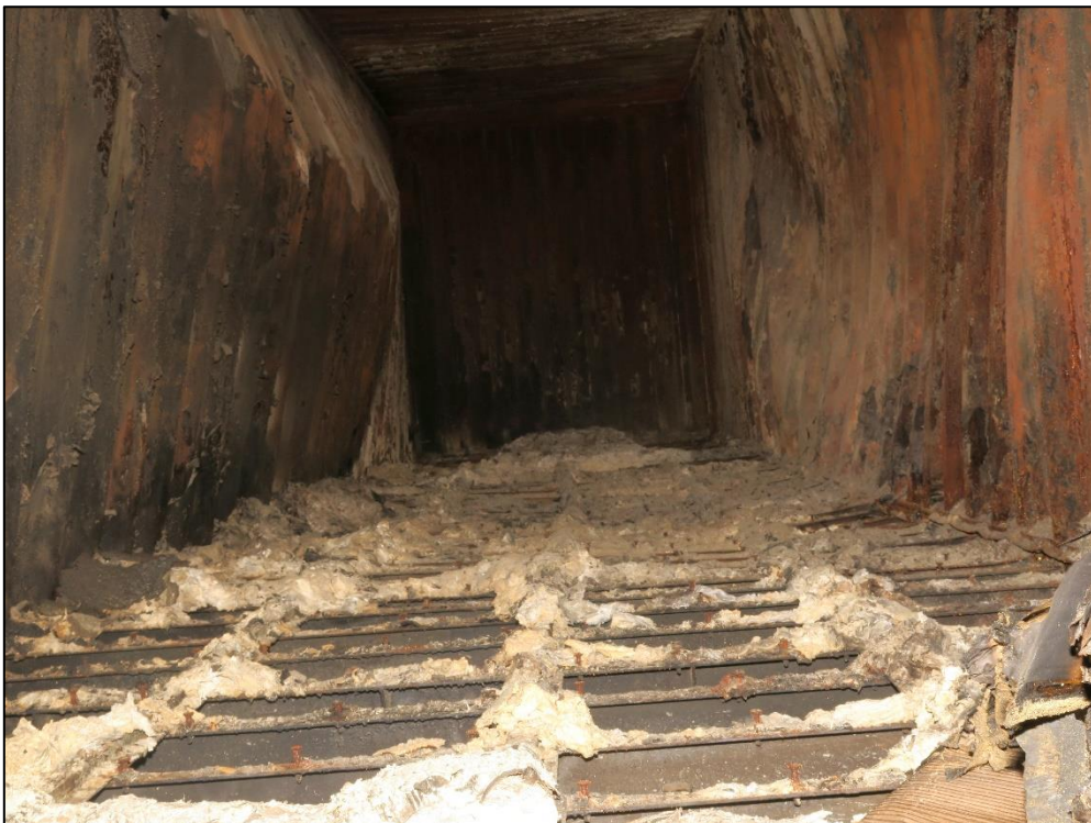
Abbildung 29: Blick in den Container auf Platz 120382 Nur geringe Brandreste; Boden vollständig verbrannt.
