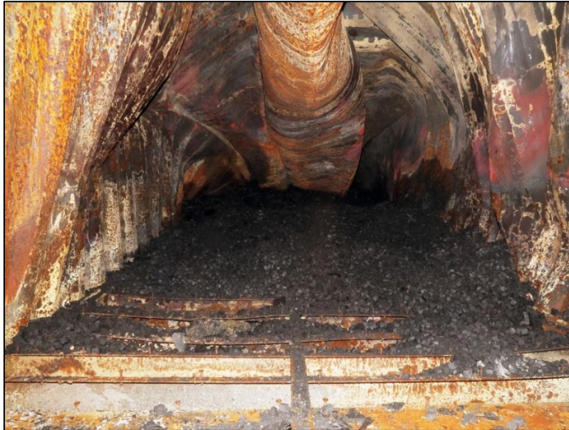
Abbildung 32: Blick in den Container auf Platz 120782
