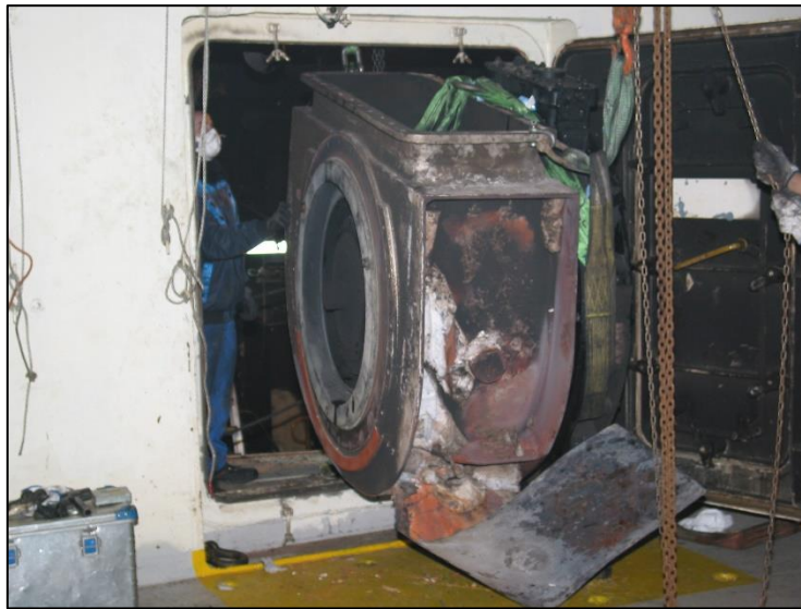
Abbildung 23: Transport von weiteren Bauteilen
