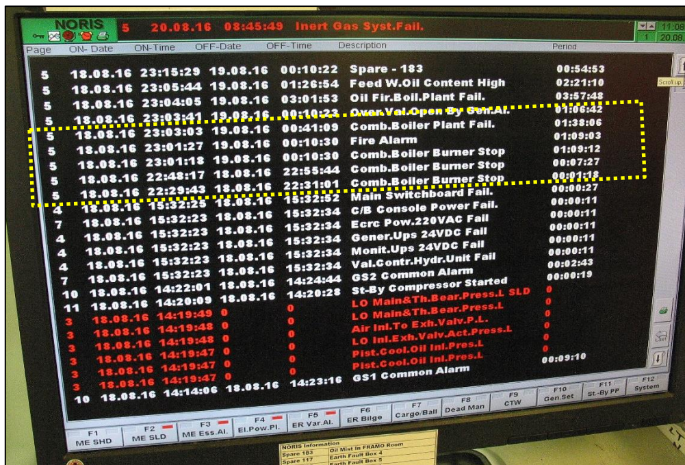
Abbildung 3: Anzeige der Alarme für den kombinierten Kessel
