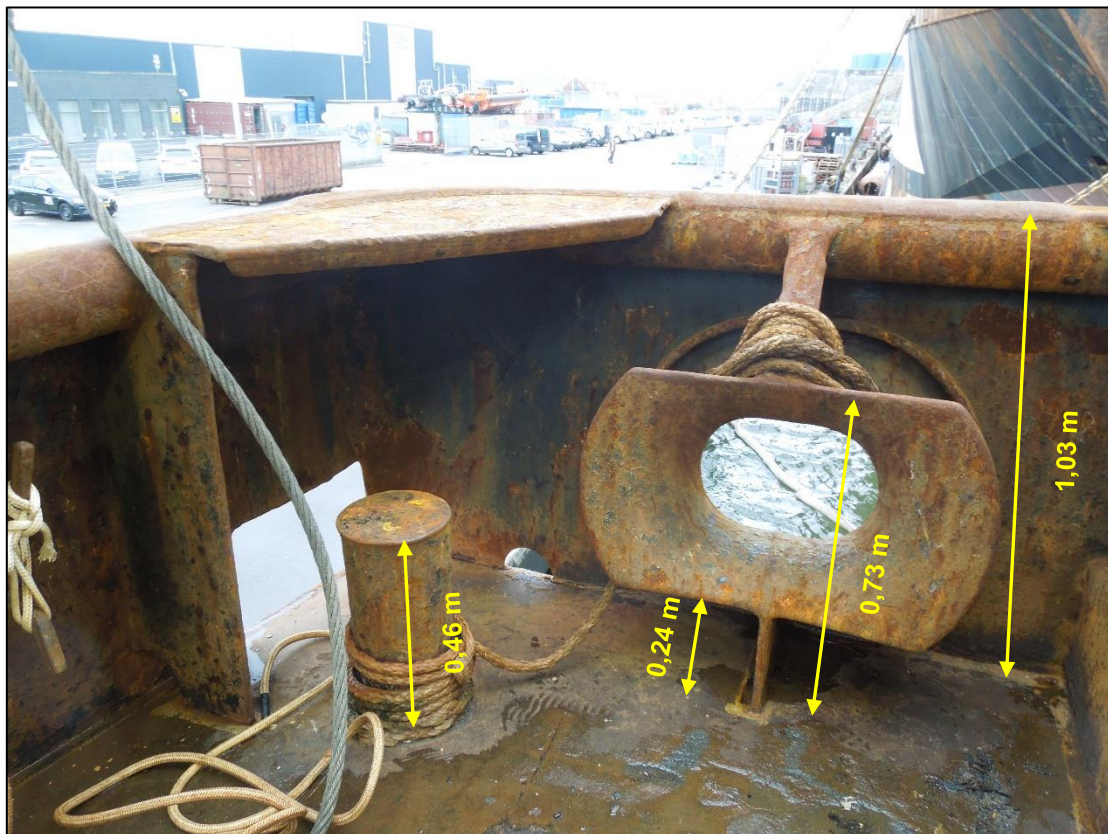
Abbildung 20: Arbeitsplatz Steuerbordseite Heck
