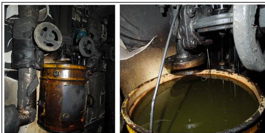
Abbildung 16: mit Thermalöl gefüllter Eimer unterhalb des Ventils
