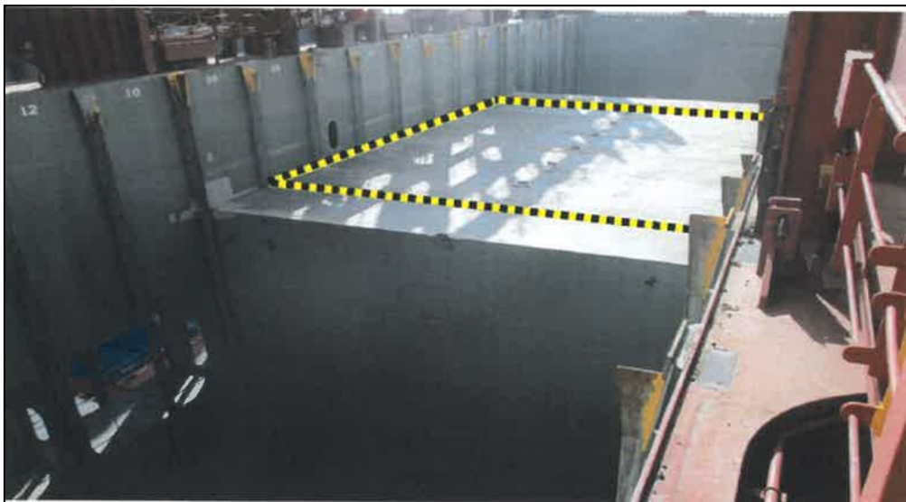
Abbildung 25: FLEET CIRCULAR – Markierungen zur Warnung vor Absturzgefahr 77
