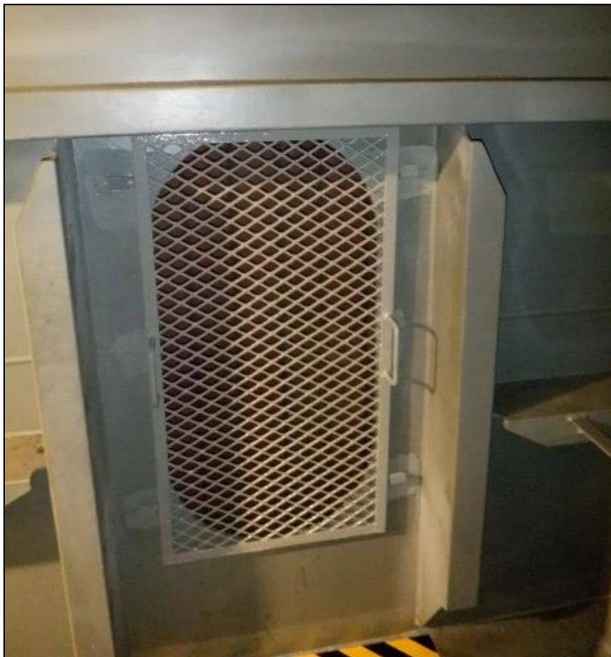
Abbildung 26: Abgesicherter Zugang zum Laderaum mit Absturzgefahr 78
