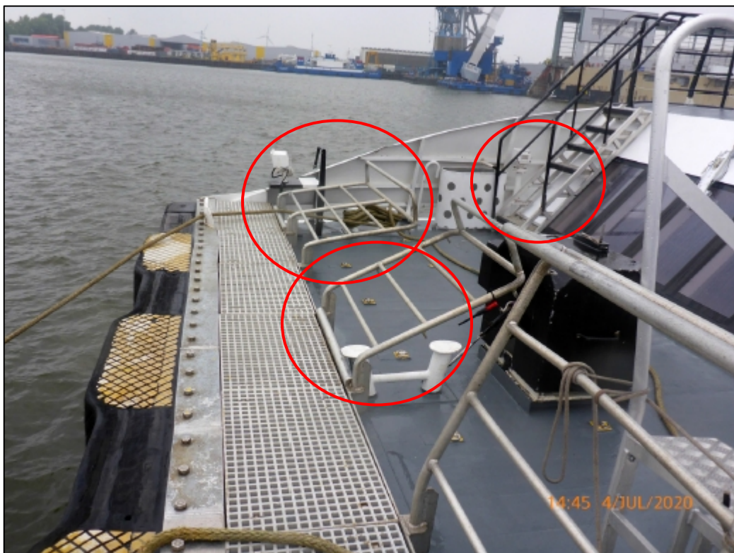
Abbildung 5: Schäden auf dem Vorschiff der SEEWIND I 9
