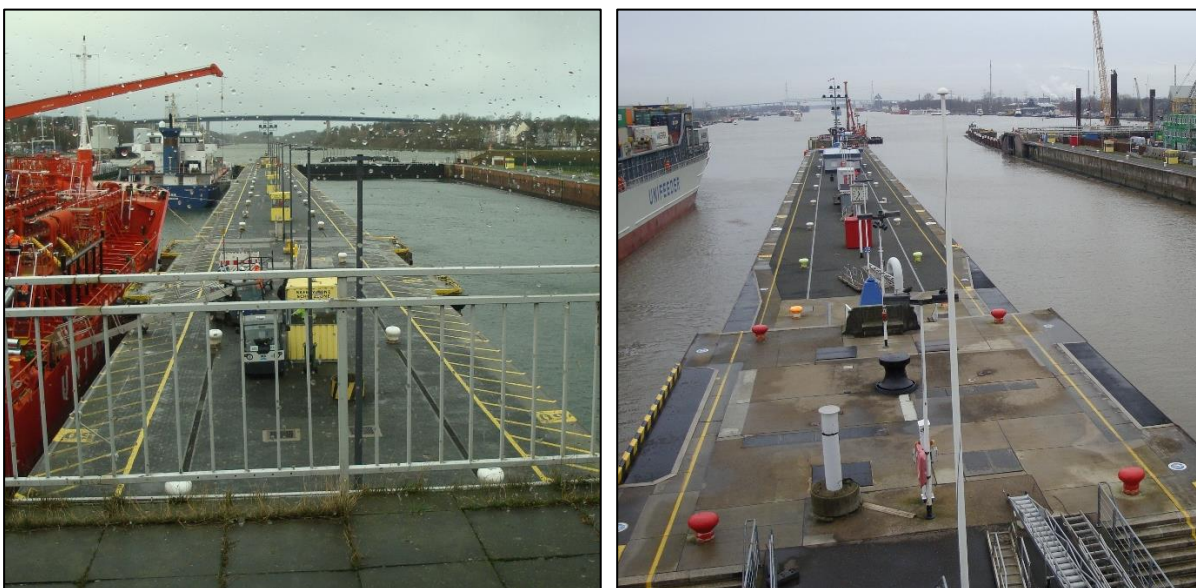
Abbildung 17: Kantenmarkierungen auf den Schleusenmauern in Kiel-Holtenau (li.) und Brunsbüttel (re.)
