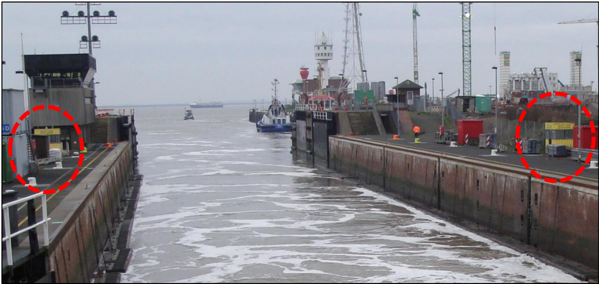
Abbildung 16: Schutzhäuschen auf den Schleusenmauern in Brunsbüttel
