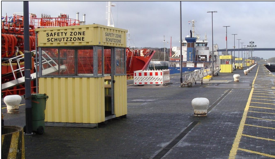
Abbildung 14: Schutzhäuschen auf der Schleusenmittelmauer in Kiel-Holtenau
