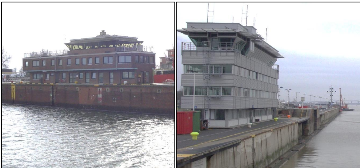
Abbildung 18: Schleusenleitstandsgebäude in Kiel-Holtenau (links) und Brunsbüttel (rechts)
