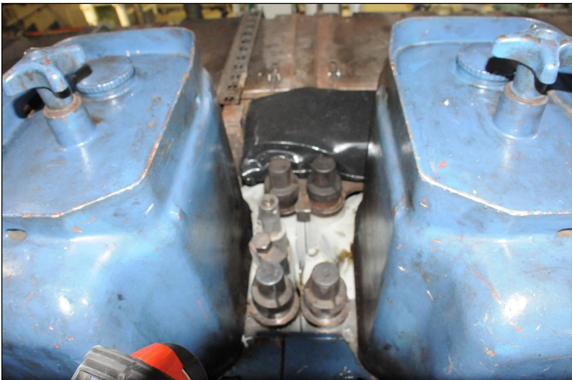
Abbildung 42: Isolierung Übergang Zylinderstation/ Abgaskanal
