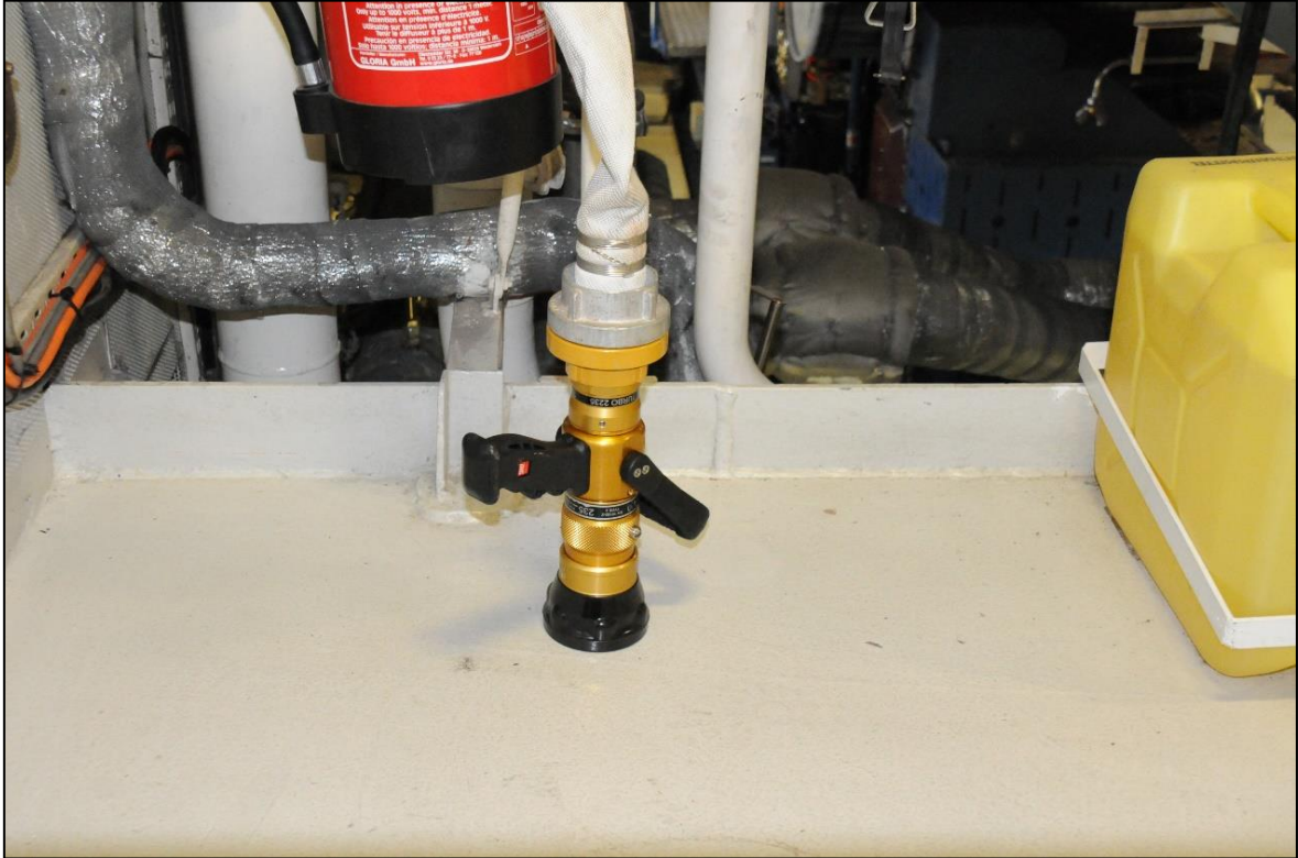
Abbildung 43: Turbo-Strahlrohr 60/130/235l/min
