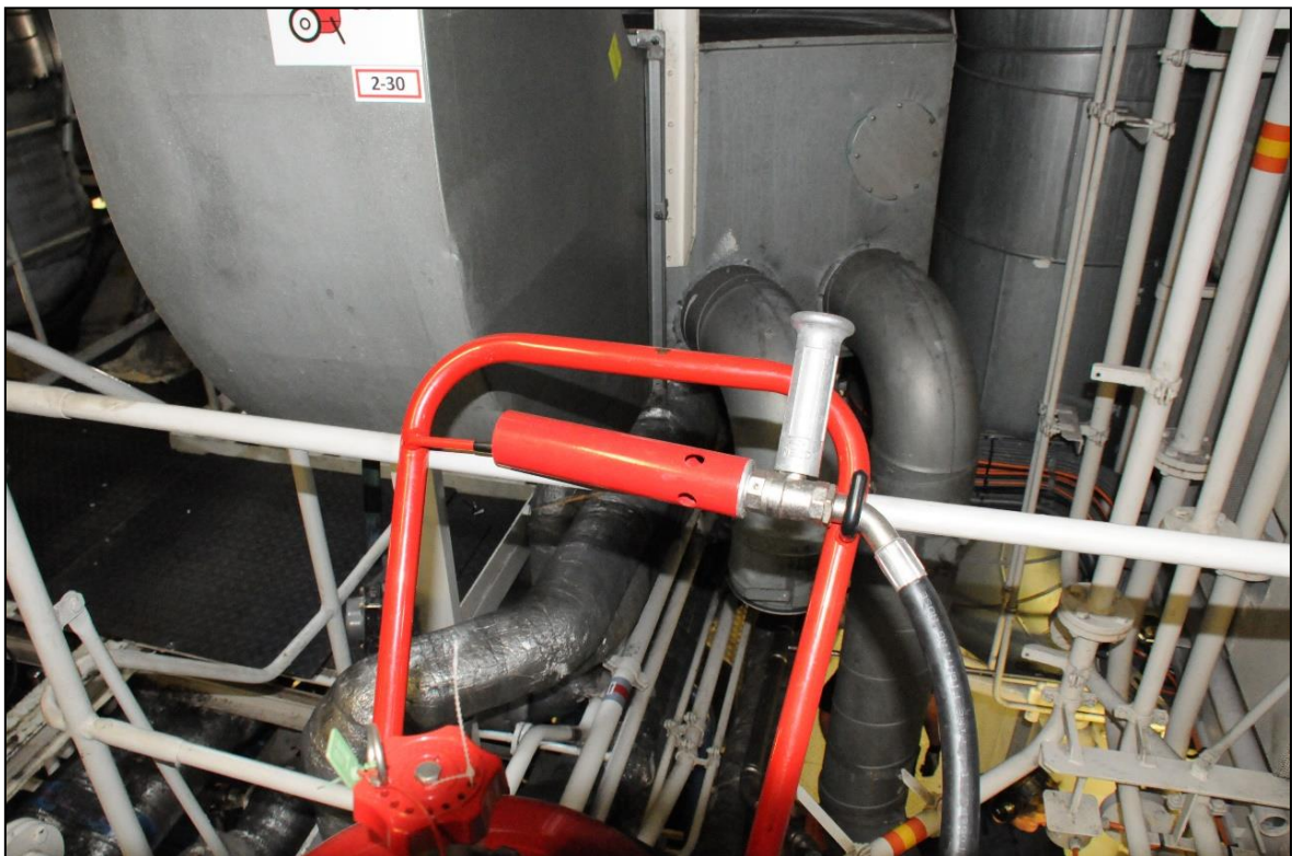
Abbildung 33: Schwertschaumrohr (Trolley) für Entstehungsbrandbekämpfung
