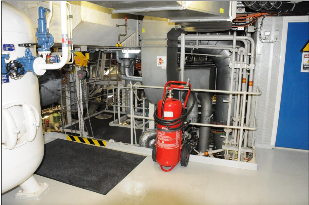
Abbildung 32: Schaum-Trolley (im Risiko Bereich)
