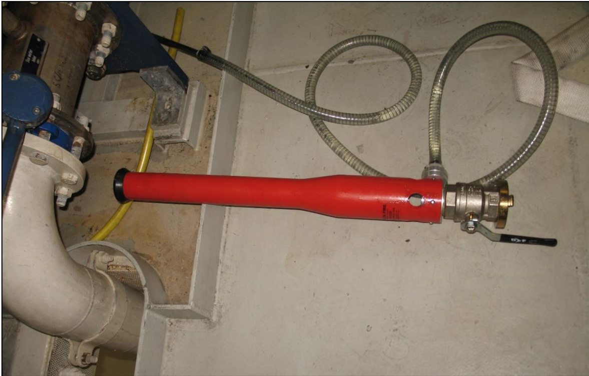
Abbildung 27: mobiles Schwerschaumrohr mit integriertem Zumischer
