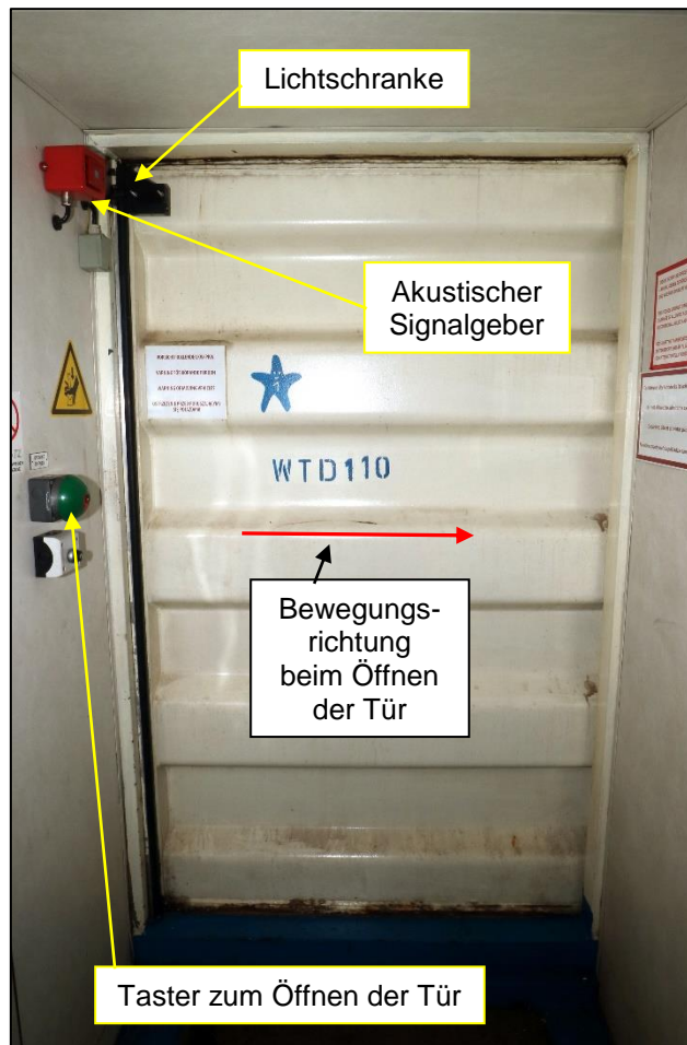
Abbildung 8: Blick auf die wasserdichte Tür 110 vom Treppenhaus aus 11
