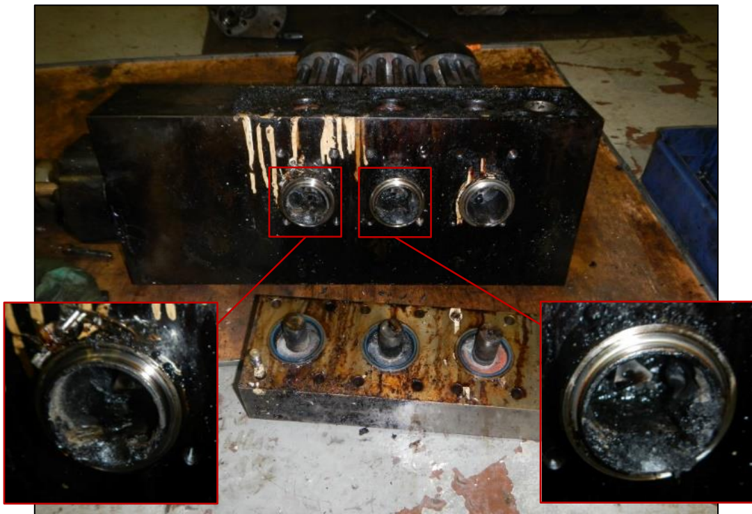
Abbildung 7: Mit teerartiger Substanz verstopfte „neutrale Räume“ einer ICU
