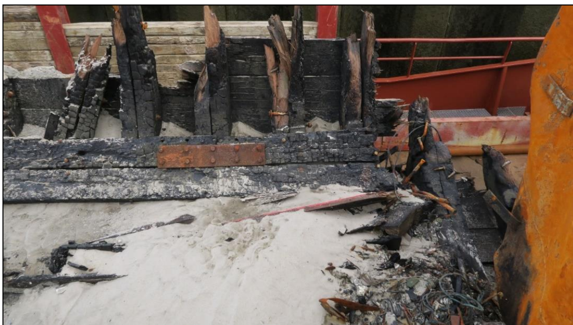
Abbildung 10: Spanten im Bereich des Fischraums auf der Steuerbordseite
