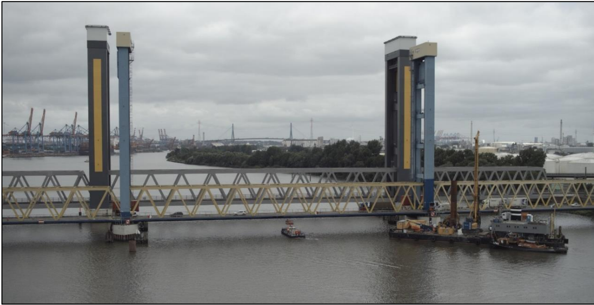
Abbildung 17: Die Kattwykbrücken, die auch zum Unfallzeitpunkt heruntergelassen waren 21
