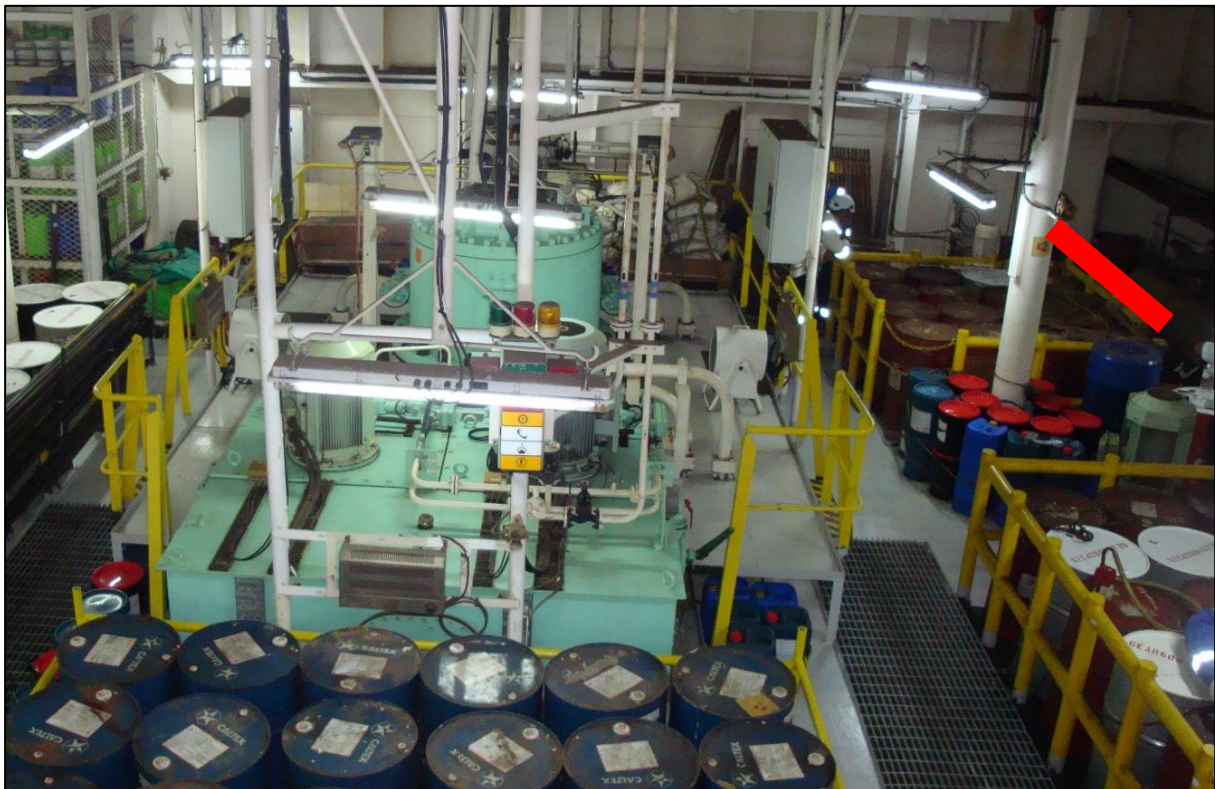
Abbildung 3: Rudermaschinenraum (Standort der Stahlplatten rot markiert)
