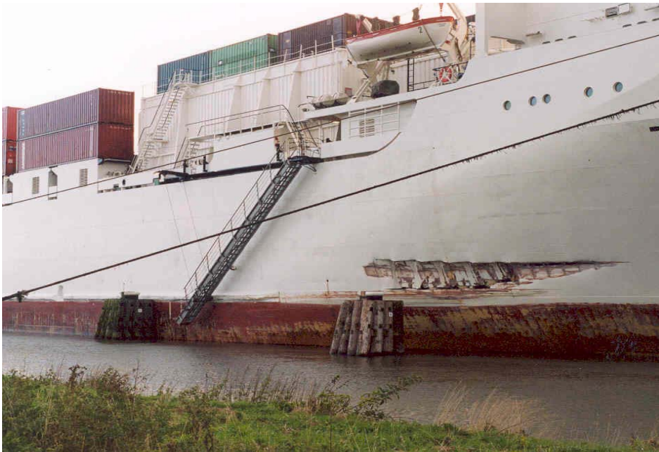
Weniger schwerer Unfall Schleusen- und Schiffsbeschädigung in Brunsbüttel am 9. Oktober 2003
