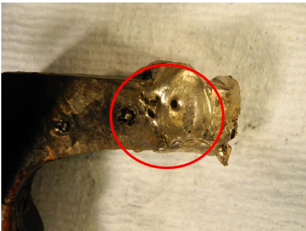
Bild 4: Makroaufnahme der Schweißung mit Lunker und Einbrandkerben
